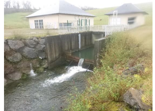
Figure 20 : Déversoir infranchissable pour la Truite fario au niveau du barrage du Gabas © BONIFACI Paul
